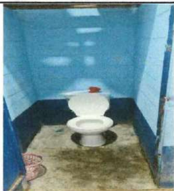
Foto 1: Instalación de azulejo en paredes de servicio sanitario, así mismo cambio de accesorios a inodoros.
