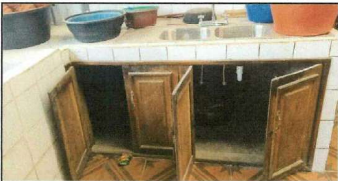
Foto 15: Restauración de puertas de madera en gabinete de cocina, debido al deterioro de las mismas.
