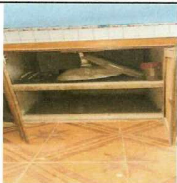
Foto 21: Instalación de azulejo en área de gabinetes y pila de cocina.
