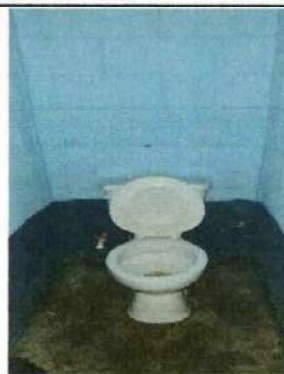
Foto 2: Instalación de azulejo en paredes de servicio sanitario, así mismo cambio de accesorios a inodoros.
