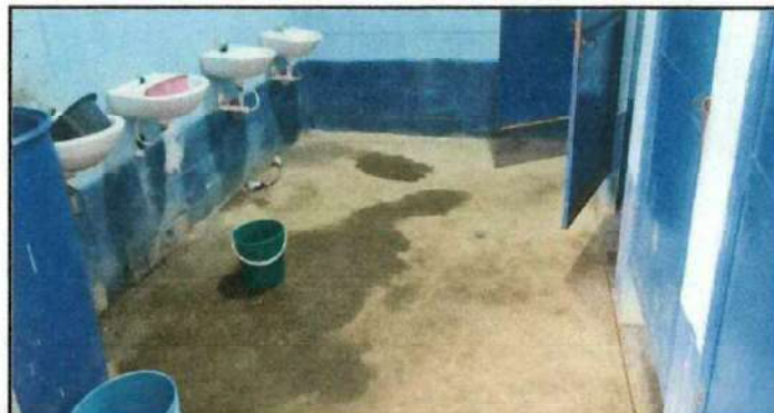
Foto 4: Instalación de piso anti derrape en servicios sanitarios primer y segundo nivel.
