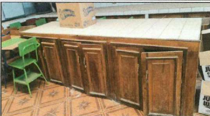
Foto 14: Restauración de puertas de madera en gabinete de cocina, debido al deterioro de las mismas.
