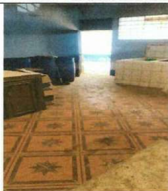
Foto 13: Instalación de piso antideslizante para interior de cocina debido al deterioro del actual.
