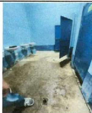
Foto 10: Aplicación de pintura en paredes, interior servicios sanitarios segundo nivel.
