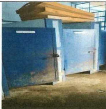
Foto 7: Restauración de puertas en servicios sanitarios primer y segundo nivel debido al deterioro de las mismas (oxidación).
