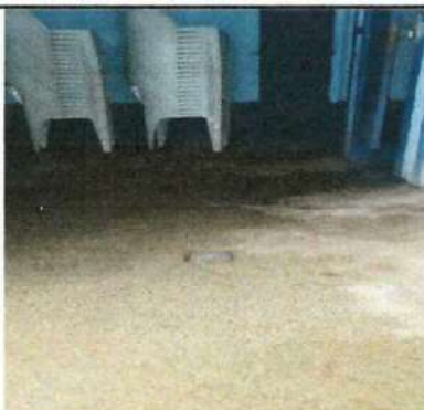
Foto 3: Instalación de piso anti derrape en servicios sanitarios primer y segundo nivel.
