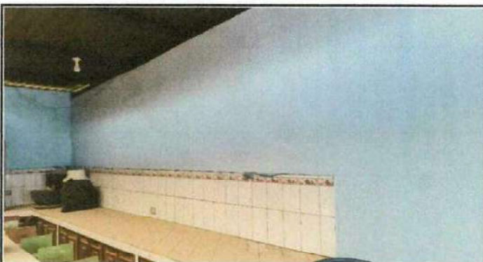
Foto 16: Mejoramiento acabado de paredes interior y exterior cocina debido al deterioro, así mismo aplicación de pintura en interior y exterior.
