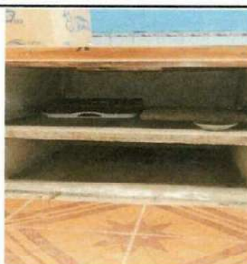
Foto 22: Instalación de azulejo en área de gabinetes y pila de cocina.
