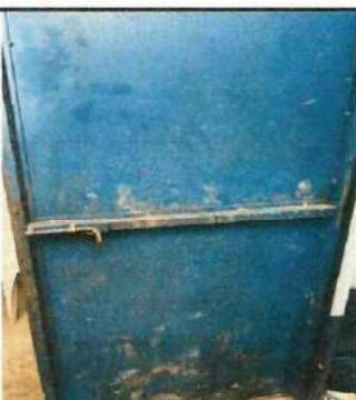
Foto 5: Restauración de puertas en servicios sanitarios primer y segundo nivel debido al deterioro de las mismas (oxidación).
