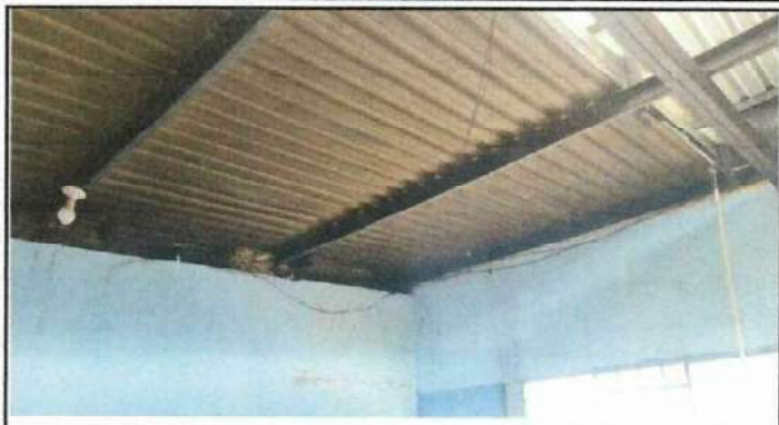
Foto 19: Mejoramiento de sistema eléctrico fuerza e iluminación, en interior de cocina (instalación de tomacorrientes dobles, plafoneras y focos led).
