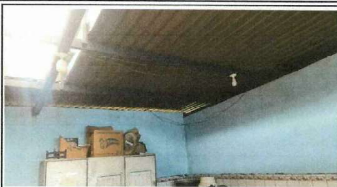
Foto 20: Mejoramiento de sistema eléctrico fuerza e iluminación, en interior de cocina (instalación de tomacorrientes dobles, plafoneras y focos led).
