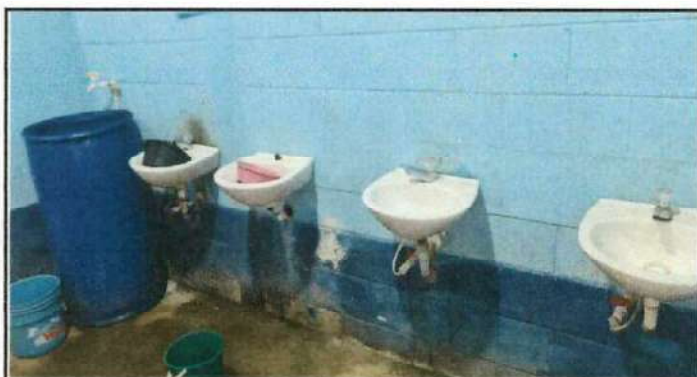
Foto 9: Sustitución y mejoramiento de modulo lavamanos servicios sanitarios segundo nivel.
