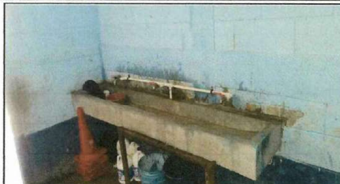
Foto 8: Mejoramiento de pila de concreto para servicios sanitarios primer nivel.
